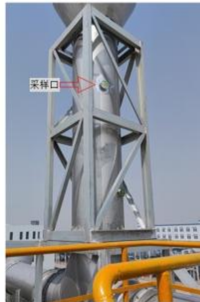
G24-25 危废间废气排放口 1-2#（采样平台、采样口、标识）
