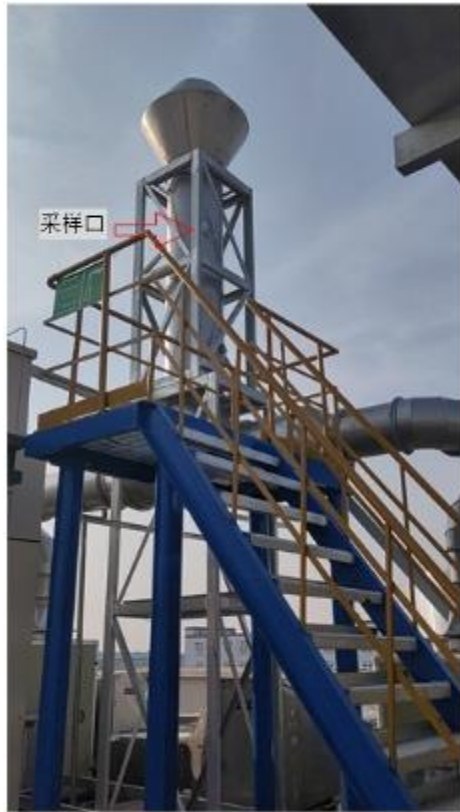
G27 中心化验室废气 2#（采样平台、采样口、标识牌）
