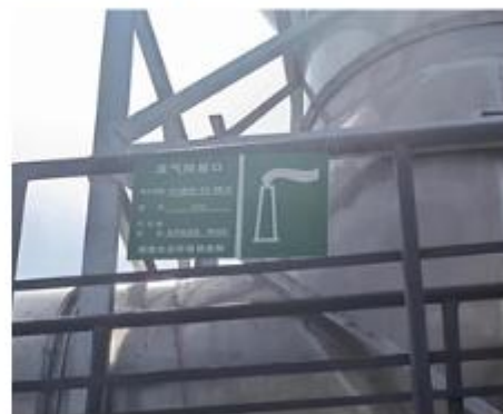
G31 中心化验室废气 6# (采样平台、采样口、标识牌)
