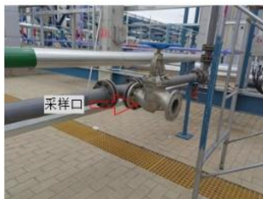
G10 氯化镁加工装置尾气排放口、采样口及标识
