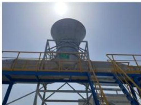
G30 中心化验室废气 5# (采样平台、标识牌)
