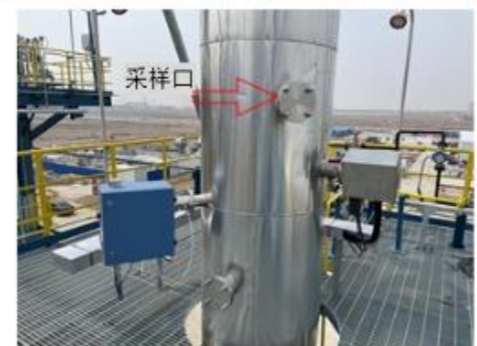
G7-1#焚烧炉烟气排放口（采样平台、标识及在线监测设备）
