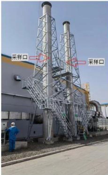
G24-25 危废间废气排放口 1-2#（采样平台、采样口、标识）
