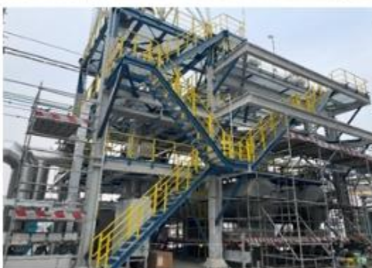
G7-1#焚烧炉烟气排放口（采样平台、标识及在线监测设备）
