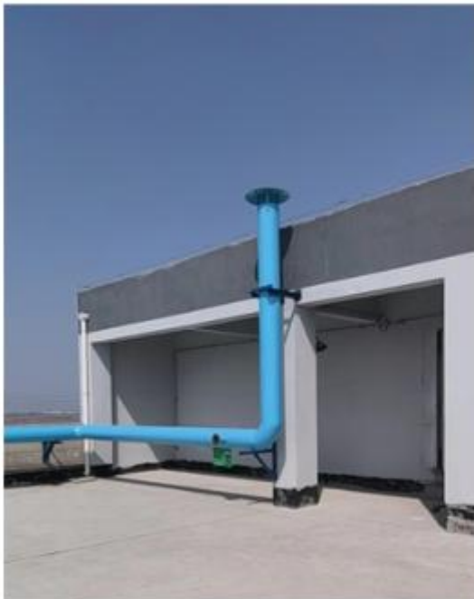
G6 银催化剂包装废气排放口（采样口、标识）
