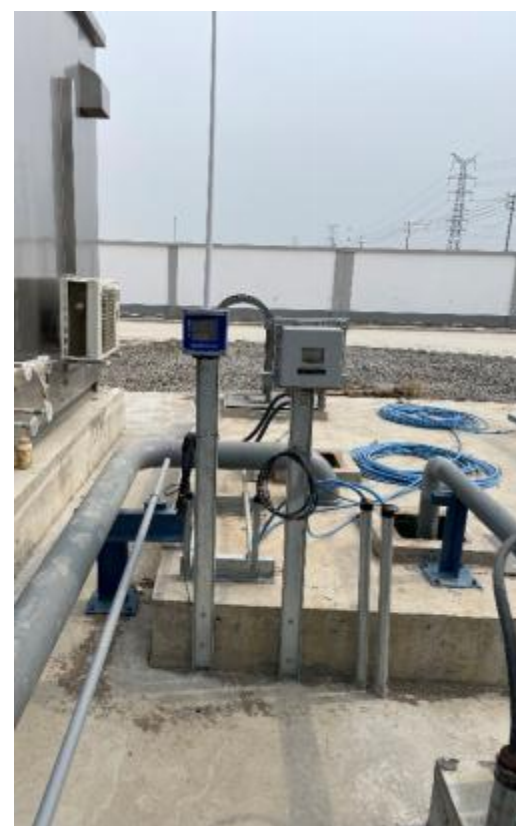
污水总排口流量计及电导率仪
