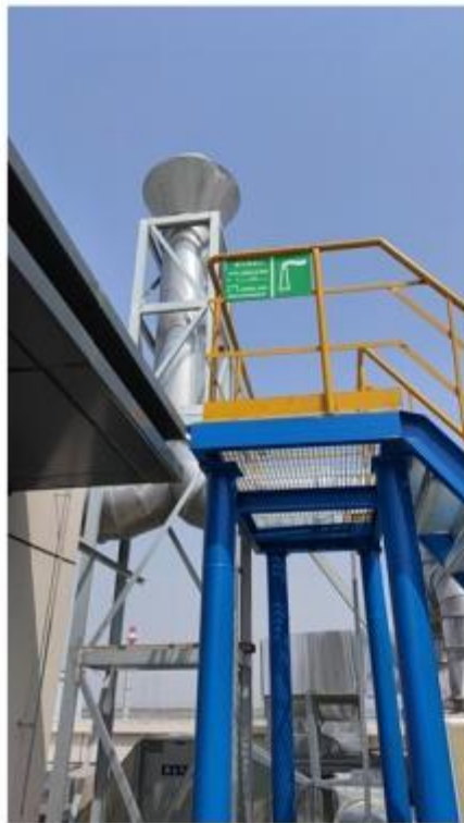
G26 中心化验室废气 1#（采样平台、采样口、标识牌）
