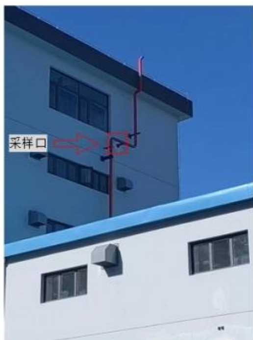
G10 氯化镁加工装置尾气排放口、采样口及标识
