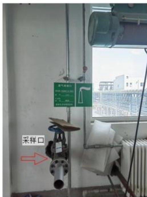
G10 氯化镁加工装置尾气排放口、采样口及标识
