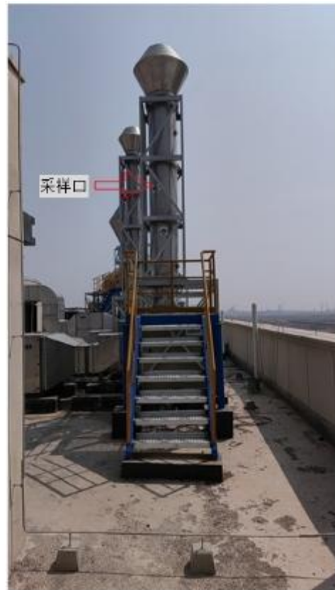
G27 中心化验室废气 2#（采样平台、采样口、标识牌）
